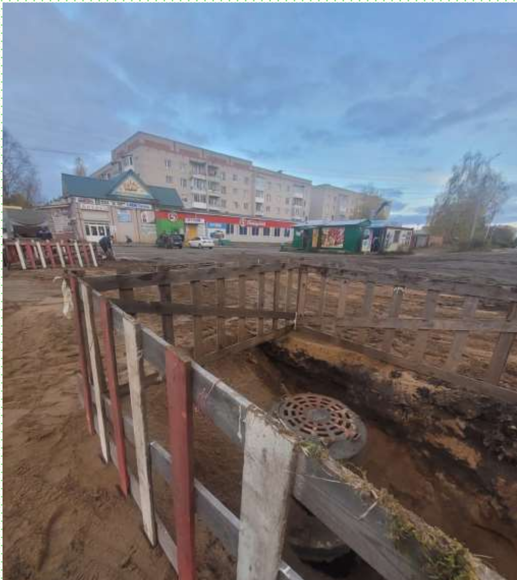
Устройство ливневых колодцев по улице 2-ая Пролетарская - улице Кирова в городе Великий Устюг
