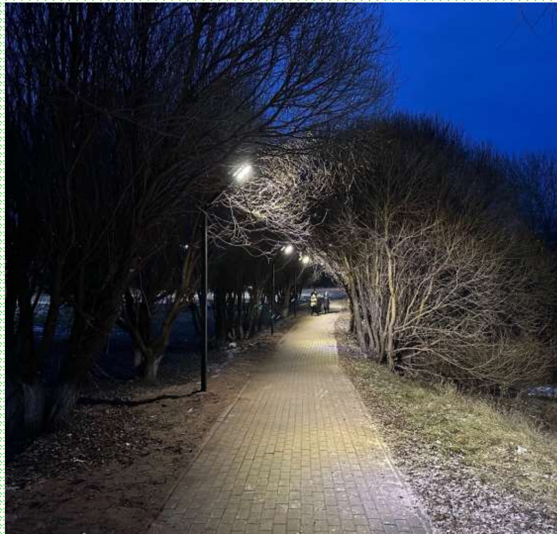
Присоединение освещения пешеходной зоны от улицы Гледенская до улицы Неводчикова к системе уличного освещения в городе Великий Устюг
