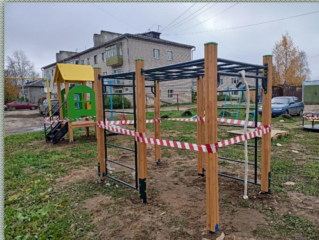
Благоустройство детской игровой площадки по адресу: г. Великий Устюг, ул.Водников,д.26
