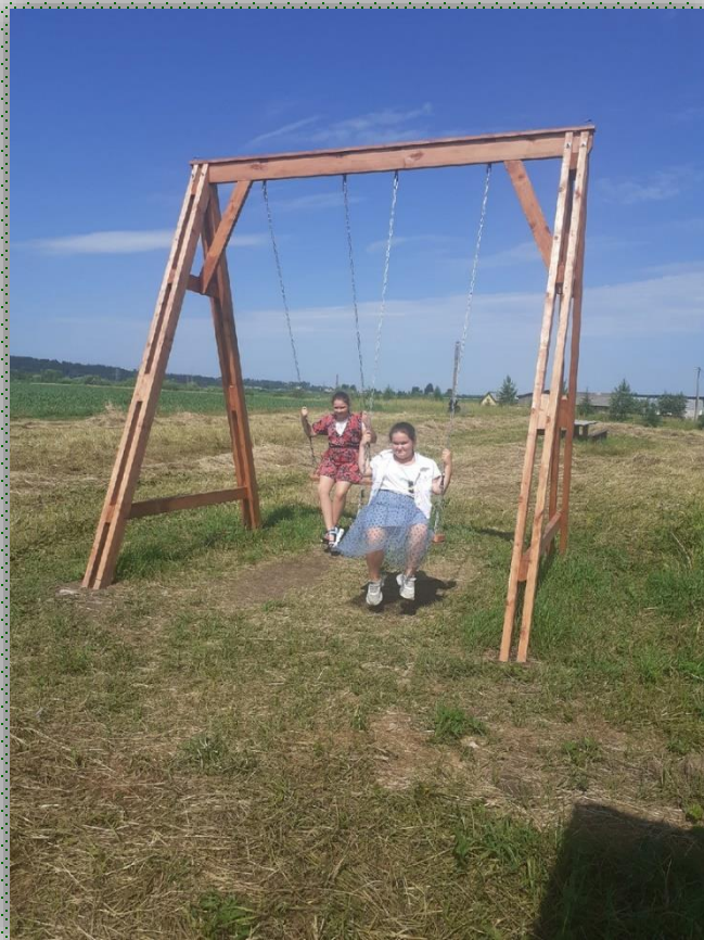
Изготовление и установка деревянной качели в д. Большая Синега
