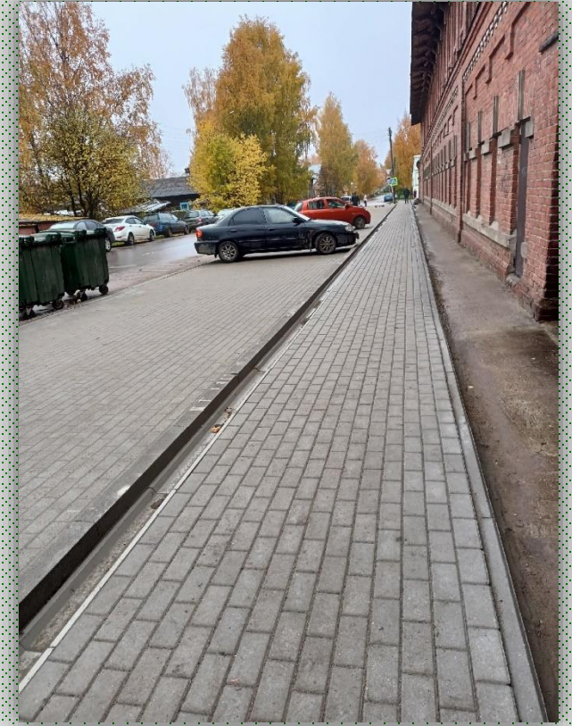
Обустройство тротуара по ул. Кирова (от ул. Красная до ул. Герцена) по нечётной стороне
