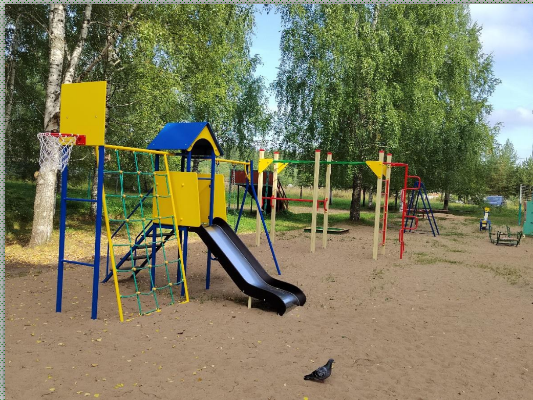
Устройство детской площадки на ул. Дачная, г. Красавино
