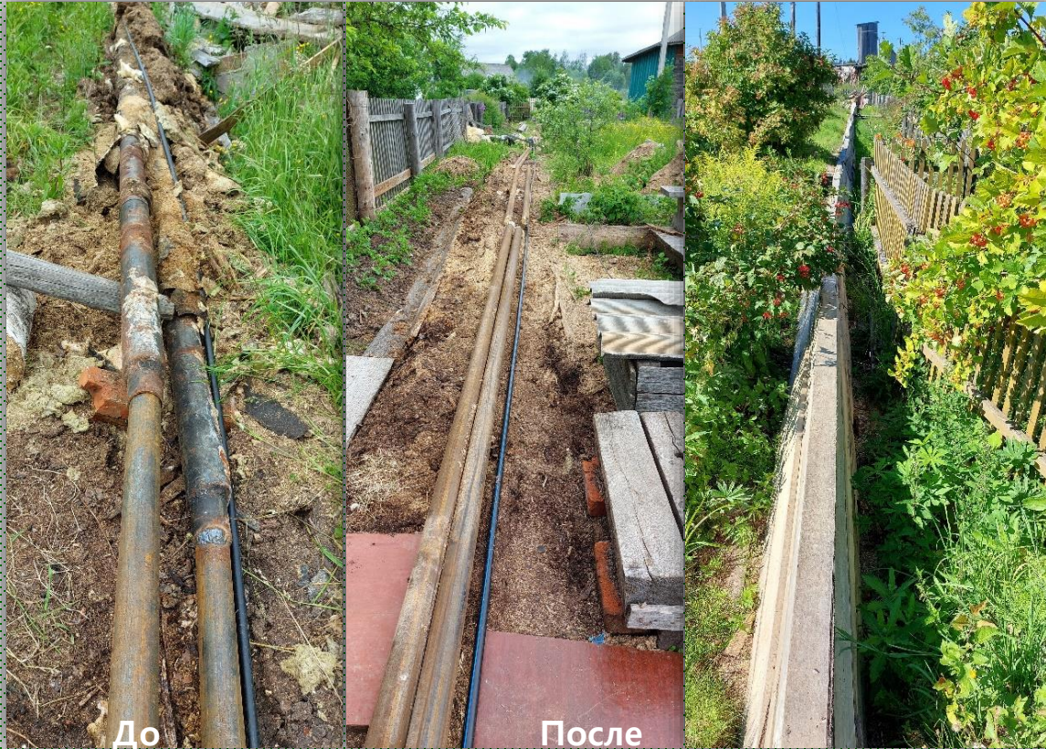
Ремонт теплотрассы по ул. Ленина в пос. Ломоватка
