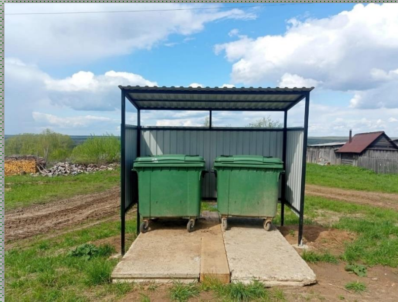
Устройство крытых контейнерных площадок с бетонным основанием в д. Теплогорье
