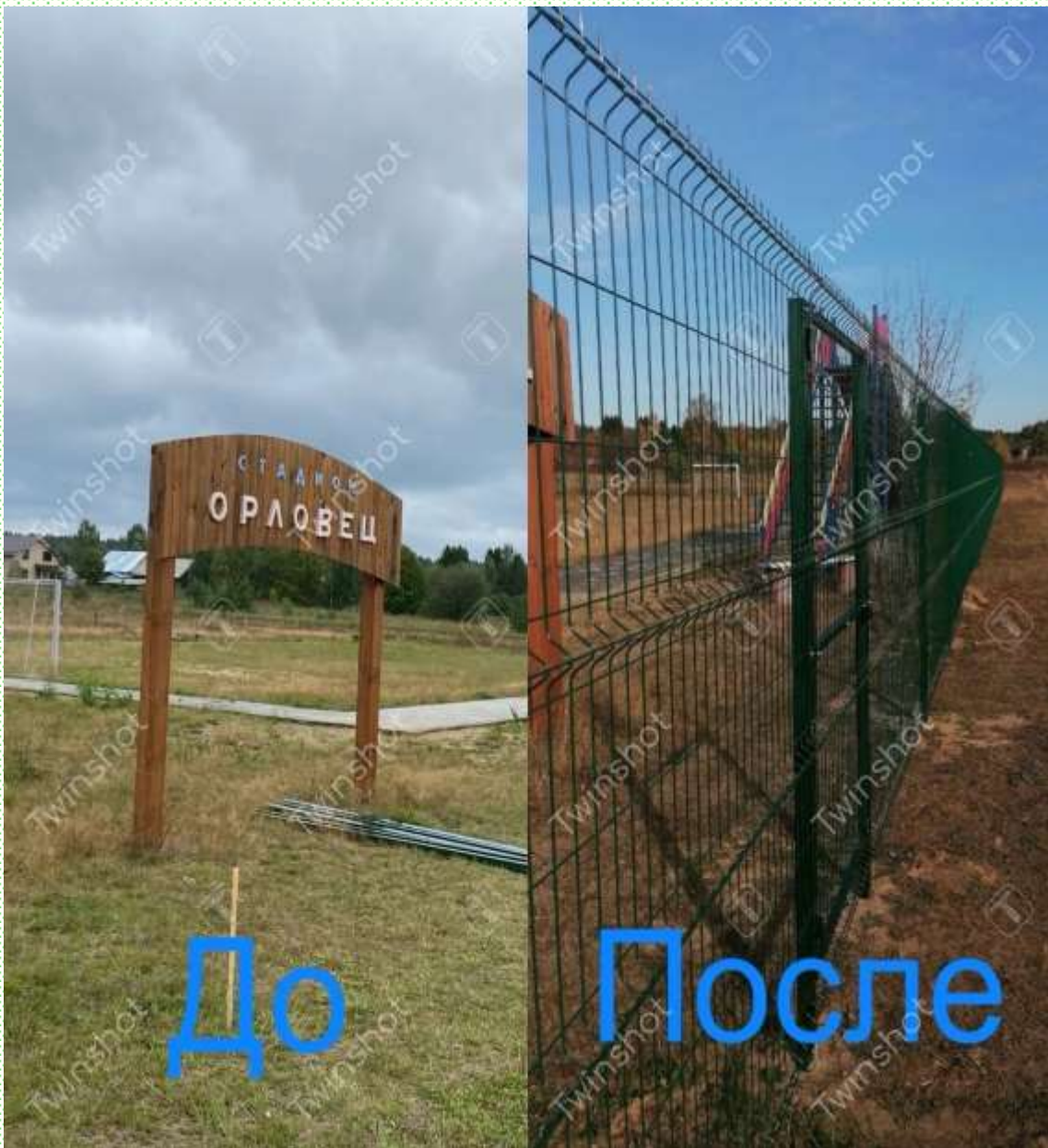
«Установка ограждения стадиона «Орловец» в деревне Чернево»
