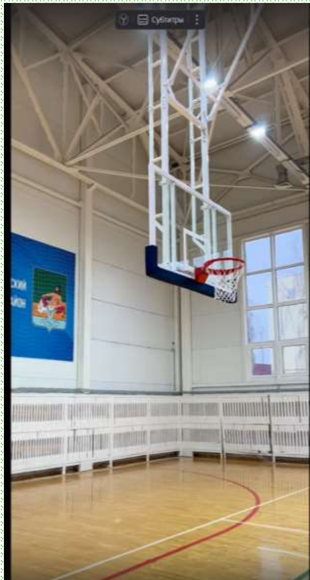
«Приобретение и установка баскетбольных складных ферм с электроприводом»
