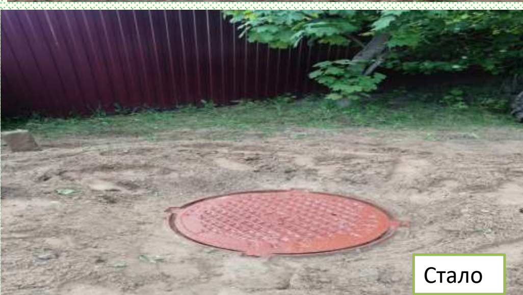
«Устройство водопроводного колодца в с. Васильевское, ул. Подлесная, д.8»
